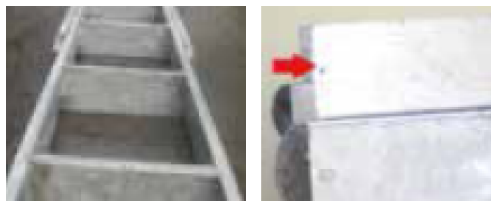
Sodi astmetel Kummist kiilud puuduvad
